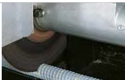
Mit geringem Druck durchtrennen Enden versäubern Cut through the conduit with low pressure clean ends
